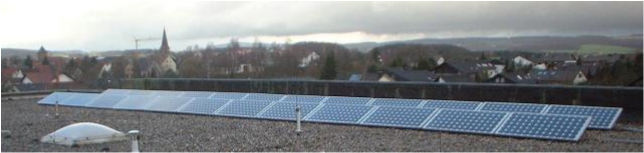
Abbildung 6-5: Flachdachmontage von Photovoltaikmodulen auf der Regionalschule Weilerbach
