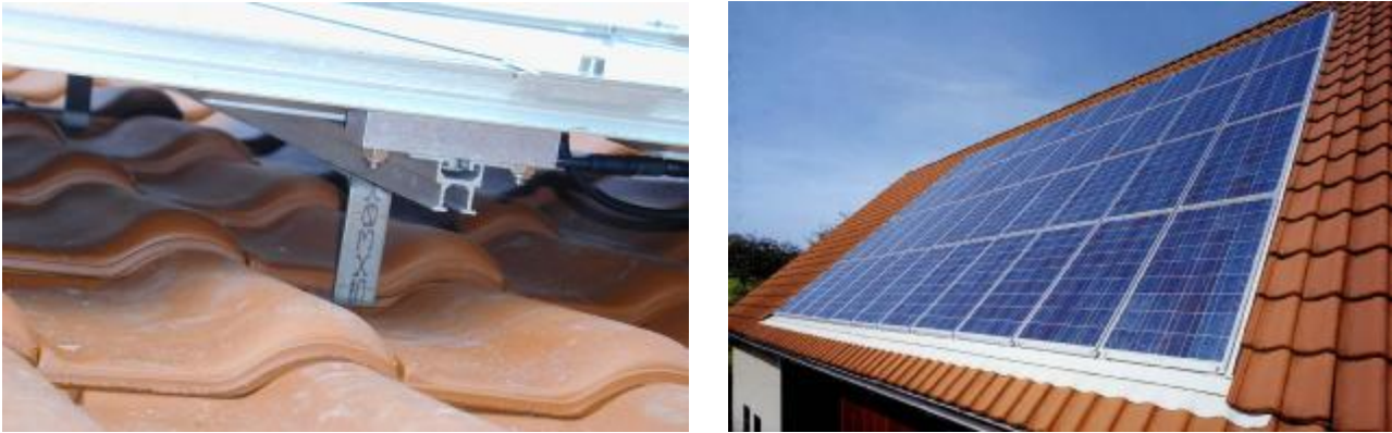
Abbildung 6-2: Auf-Dach-Montage (links) und In-Dach-Montage (rechts)
