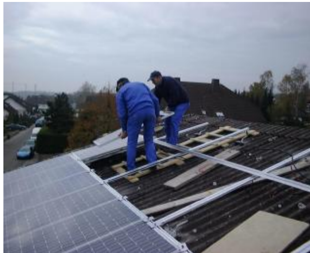
Abbildung 6-1: Montage einer Photovoltaikanlage
